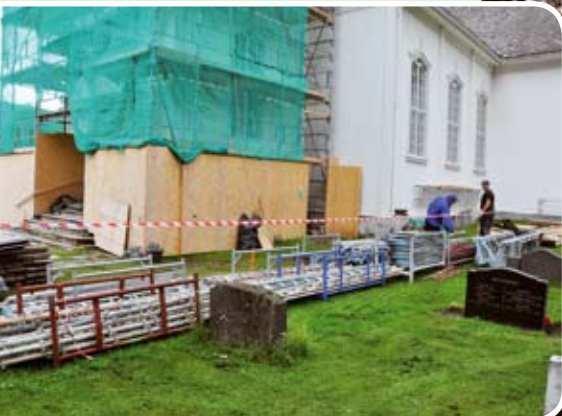
Rehabilitering Nes kirke side 12
