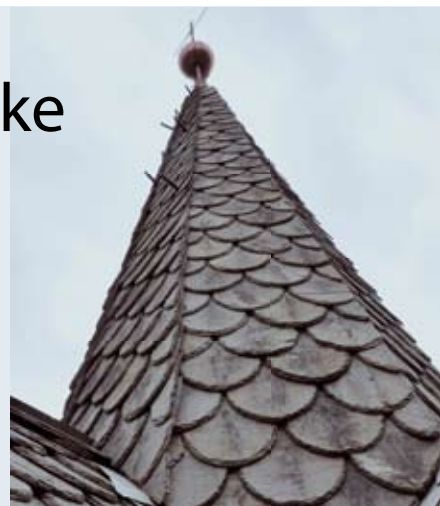
Ny skifer dekker det øverste tårntaket
