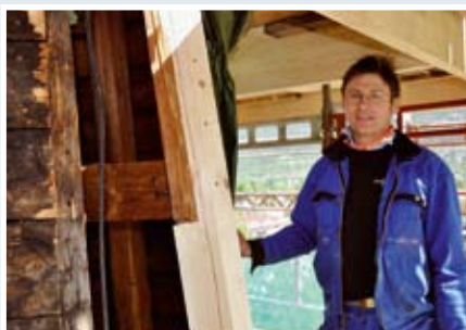
Snekker Franck Favris viser frem en av de 8 meter lange bjelkene som er bærekonstruksjonen i tårnet. På grunn av råtne måtte ca 3.5 meter av denne bjelken skiftes ut.
